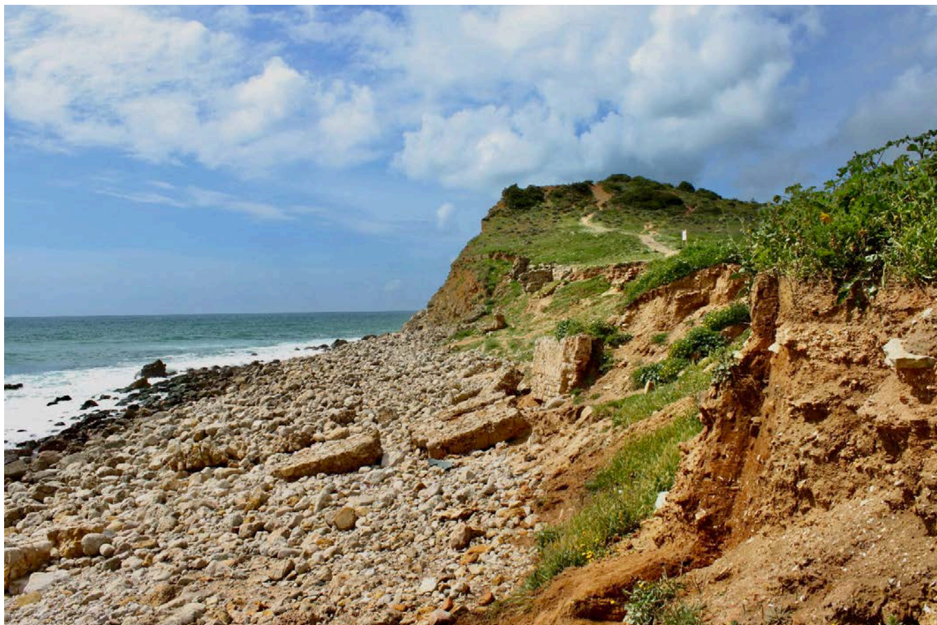
Figura 2. A erosão provoca a destruição contínua dos edifícios romanos salientes no talude da praia.
